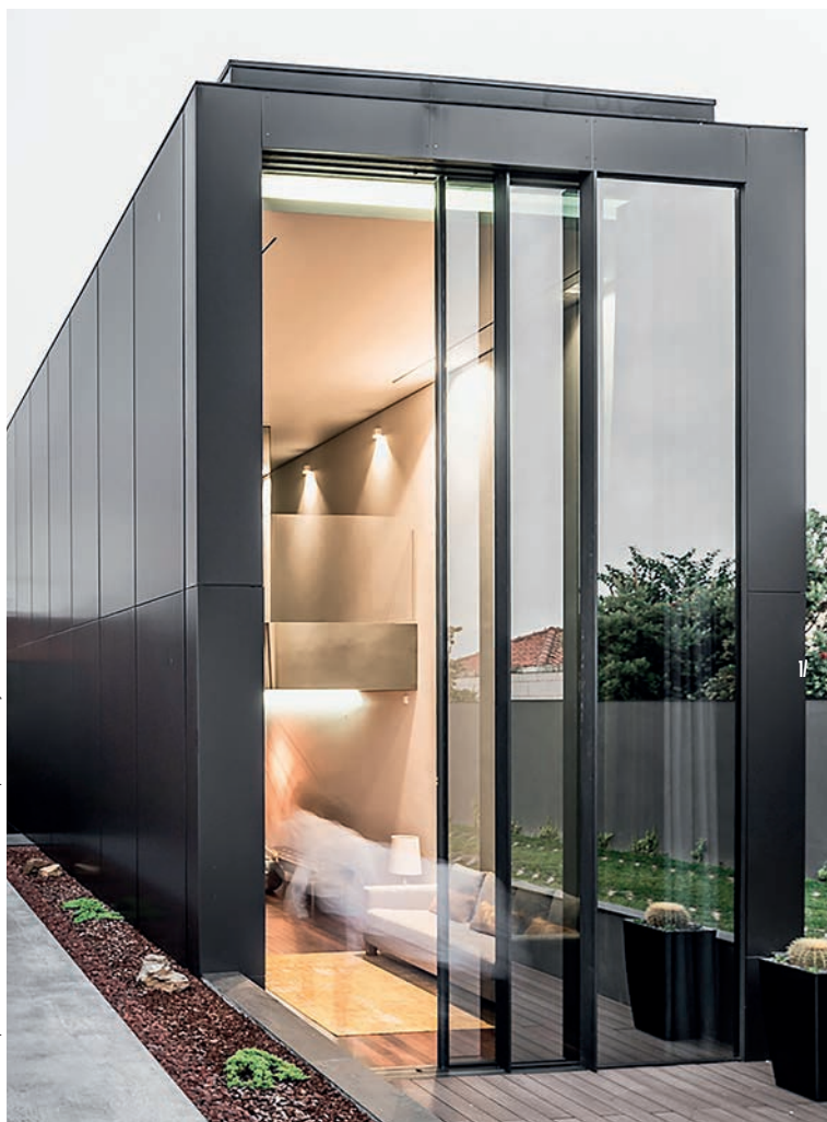
©Villa Carrapata, Architecte : Andreia Oliveira, photo DR Hyline.
